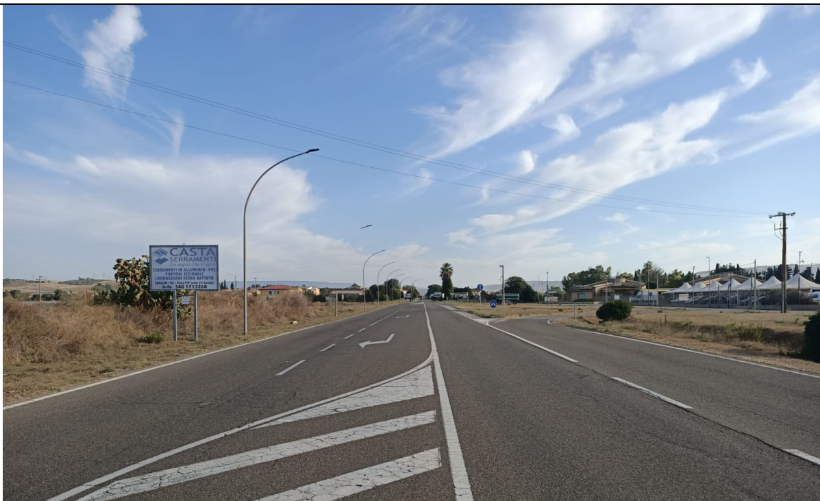
Stato ante intervento
