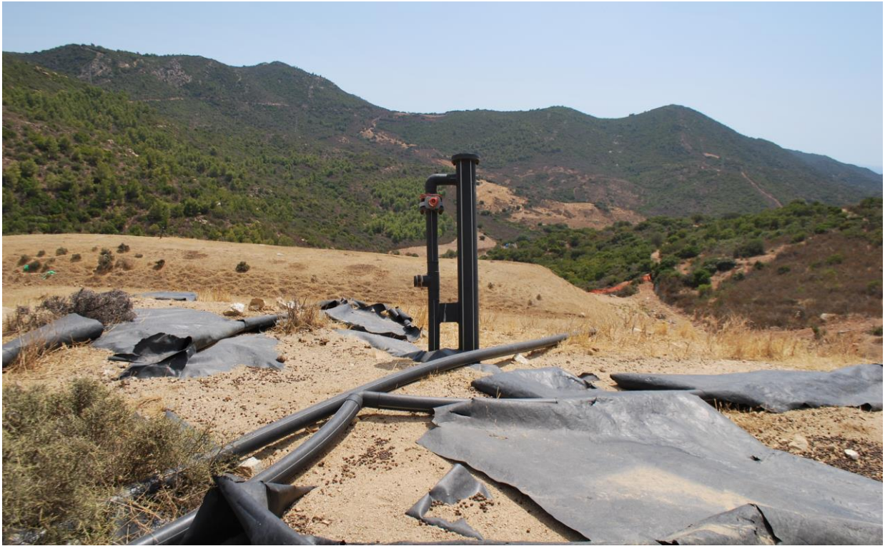
Figura 11 Testa pozzo presente in discarica
