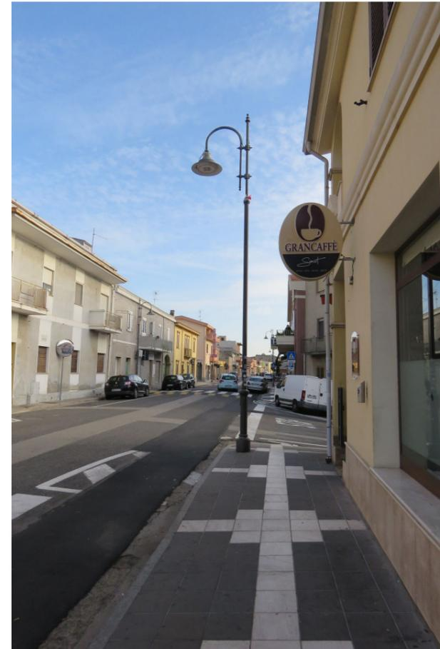
*Pavimentazione con disegno geometrico in lastre quadrate in basalto e arenaria, del marciapiede della via Nazionale di Monastir*
