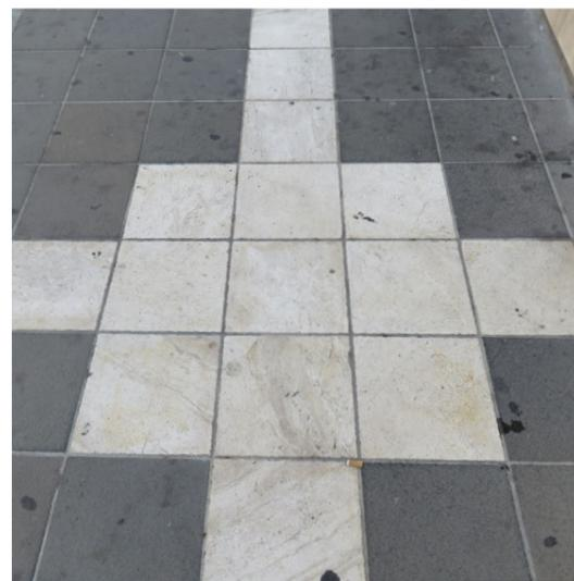
*Pavimentazione in lastre quadrate di arenaria e basalto (disegno geometrico)*
