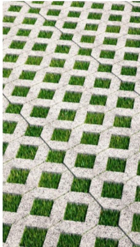
*Pavimentazione semipermeabile con elementi autobloccanti realizzati in calcestruzzo vibrocompreso, posato su un letto di sabbia.*
