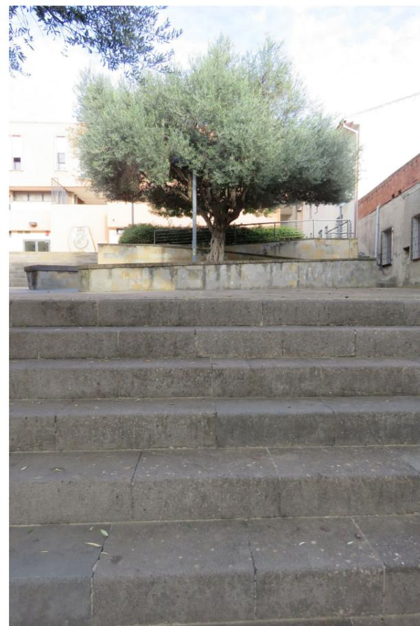
*Pavimentazione con lastre in basalto e arenaria della piazza Municipio di Monastir*
