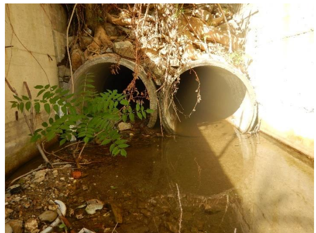
Figura 4: Sbocco del primo canale tombato
