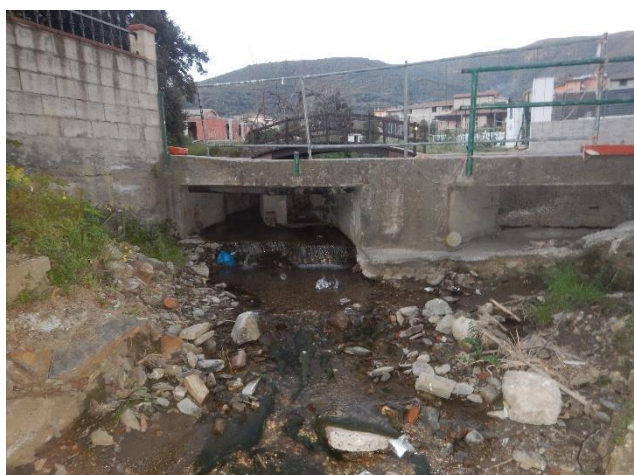
Figura 13: Ponte in Via Vittorio Emanuele – Vista da valle
