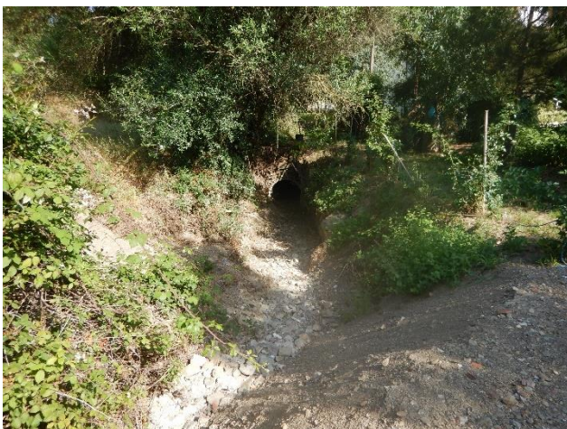
Figura 3: Alveo nel tratto subito a monte del primo canale tombato
