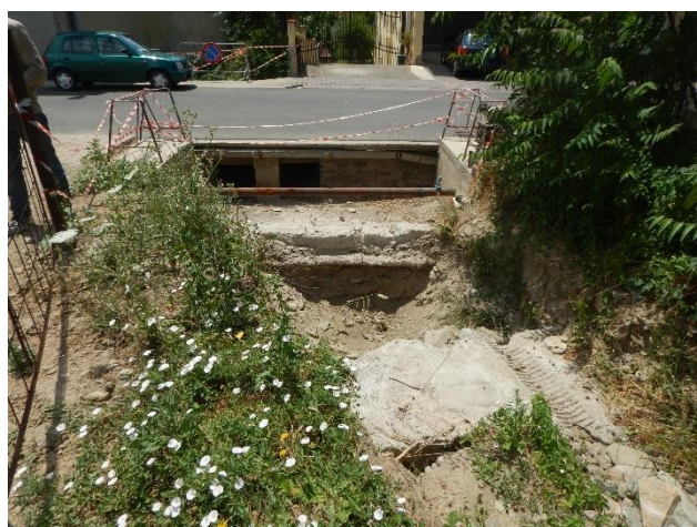
Figura 14: Ponte di Via Vittorio Emanuele – vista da monte
