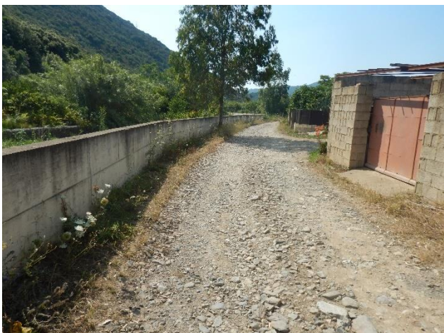
Figura 17: Ponte di Via Antonio Congia – vista dalla strada
