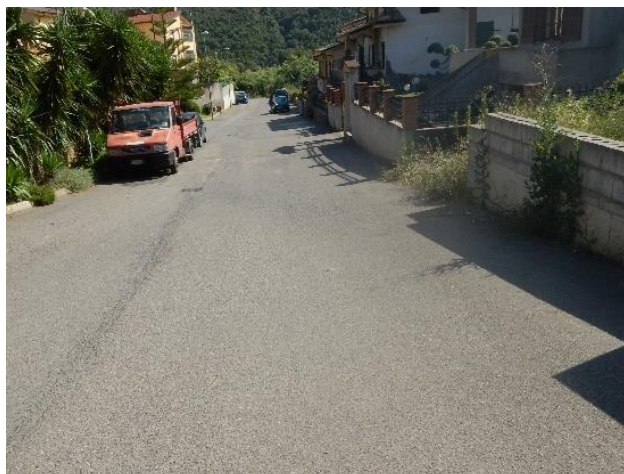
Figura 7: Vista di Via Velio Spanu e Via A. Aru, sotto le quali scorre il tratto tombato di valle.
