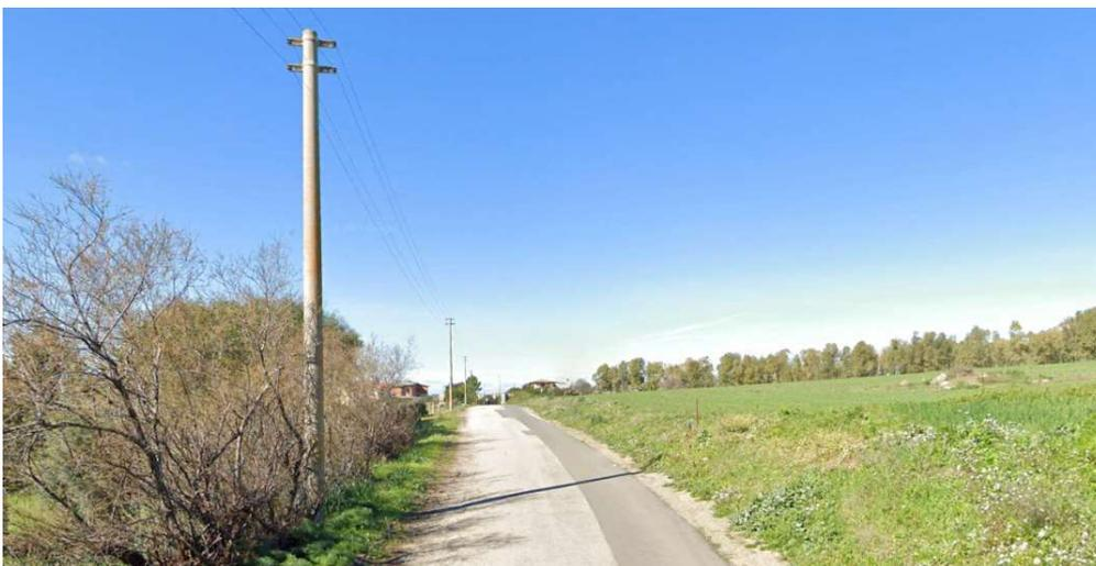
La proposta progettuale prevede l'adeguamento della sezione stradale ad un E "Urbana di quartiere con corsie di 3.00 per senso di marcia, banchina in destra transitabile di 30 cm, separazione, mediante elementi fisici, tra carreggiata e percorso ciclabile, percorso ciclabile in sede propria a doppio senso di marcia della larghezza di 2.50 m, banchina in destra non transitabile di 1.00 m utile alla sistemazione dei blocchi di sostegno e dei pali di illuminazione.
