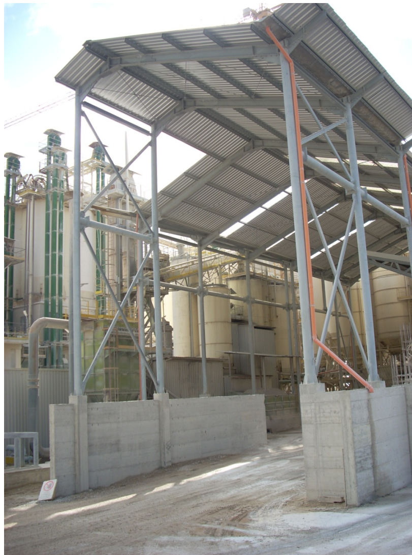
Foto n. 4: vista del capannone chiuso in fase di realizzazione per lo stoccaggio dei materiali inerti.
