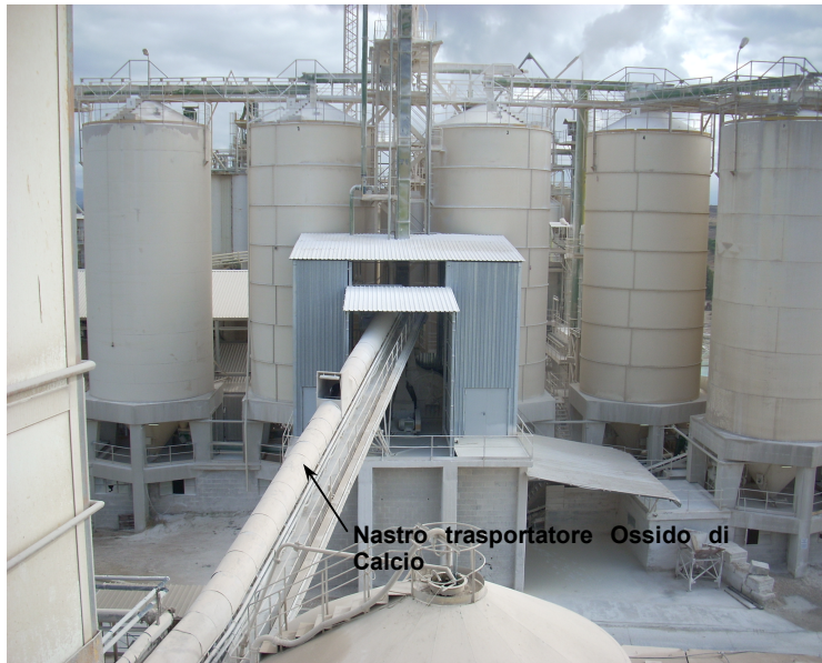
Foto n. 3: vista del nastro trasportatore chiuso che porta l'Ossido di Calcio dal forno ai sili di stoccaggio.
