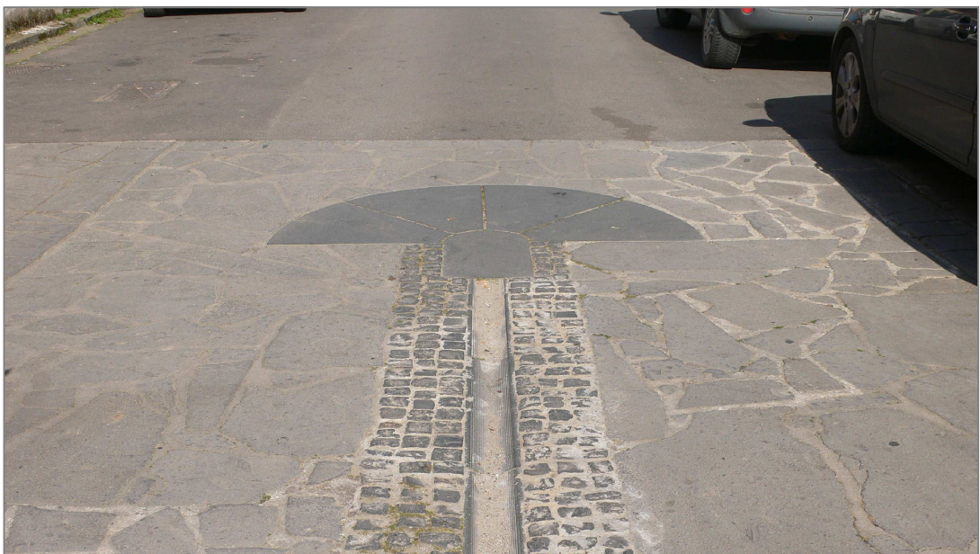
3- Pavimentazione monomaterica particolare soluzione di chiusura e griglia.
