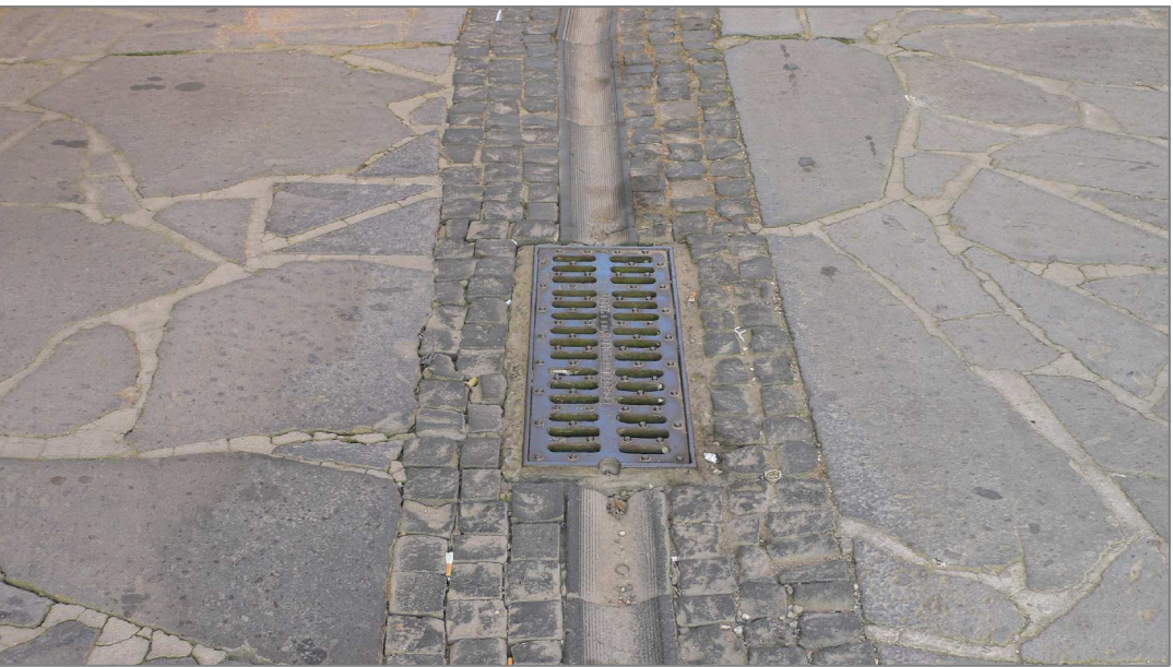
3- Pavimentazione monomaterica particolare soluzione di chiusura e griglia.
