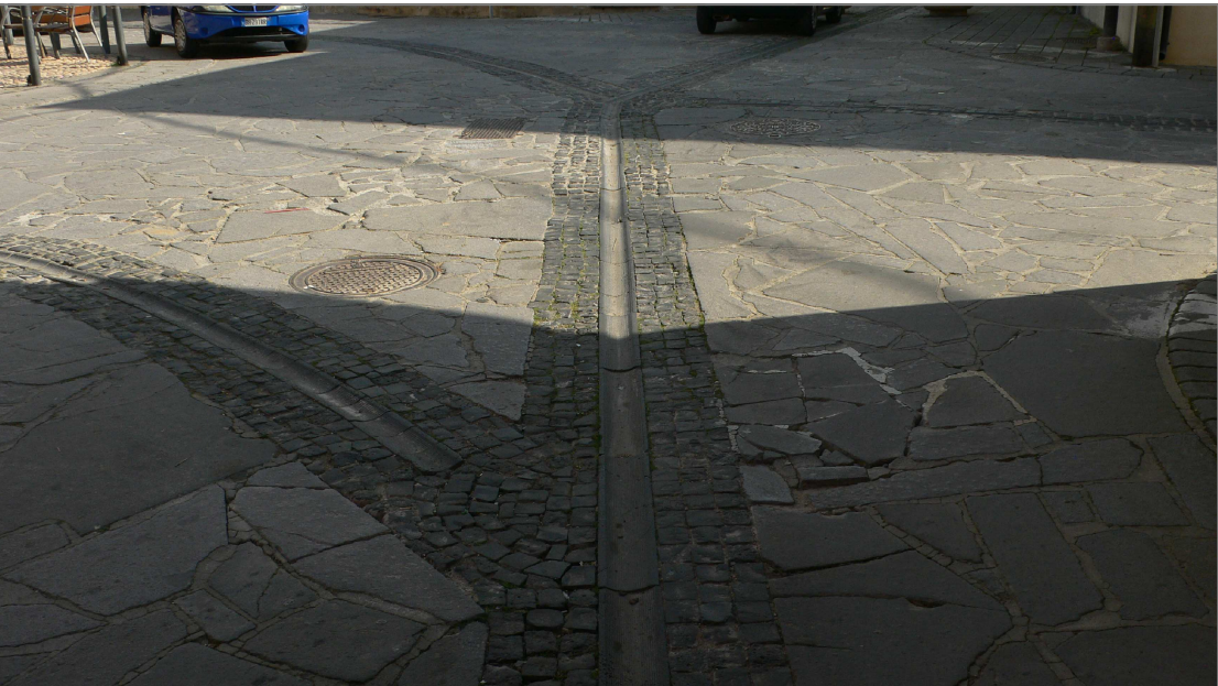
2- Pavimentazionomaterica in basalto - particolare intersezione stradale
