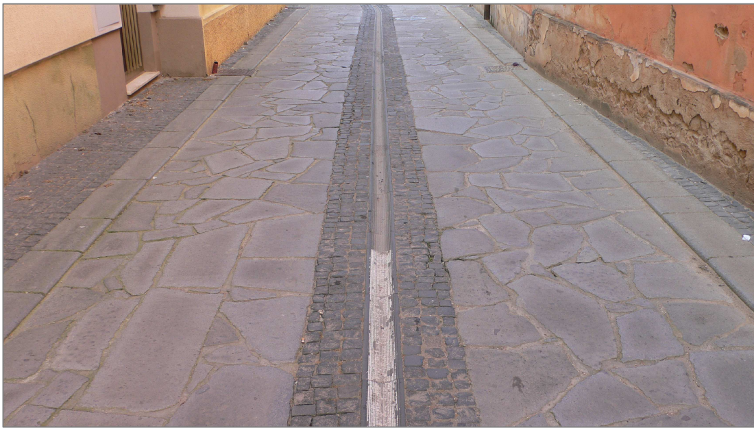
1- Pavimentazione monomaterica in basalto costituita da conci irregolari di varie forme e fascia in sanpietrini di colorazione più scura e canaletta centrale di compluvio realizzata con conci arrotondati.
