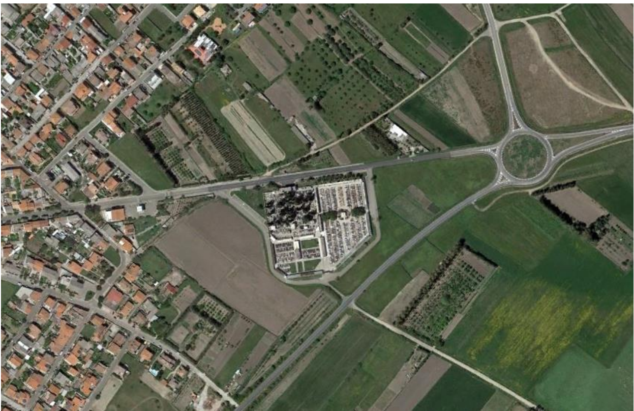
Figura 14 - Immagine satellitare dell'area cimiteriale - 2017 (Google Earth)
